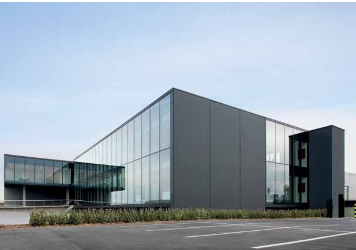
Het hele gebouw is modulair opgevat. Letterlijk. Mocht je de kantoren willen uitbreiden, dan kun je de betonplaten aan de zijkant wegnemen en een aanbouw voorzien. De traphal is bewust aangebouwd: op die manier kan de trap de verbinding vormen tussen het oude en eventuele nieuwe kantoor.
